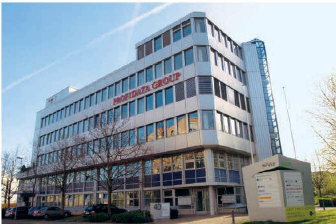
Hauptsitz der Profidata Group in Zürich, von Sympatron für die Zukunft abgesichert
